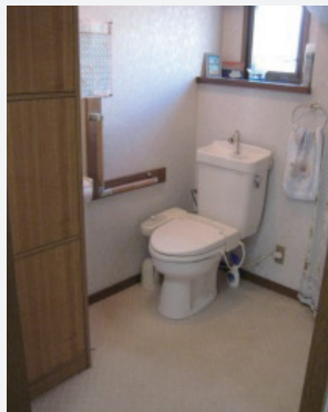
扉は折り戸、広いスペース、 L字手すり
